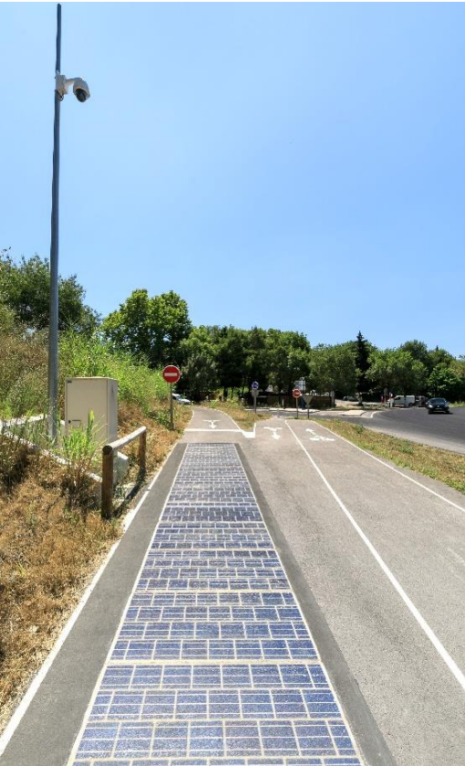
Alimentation d'une caméra de supervision du trafic routier (Montpellier Méditerranée Métropole)
